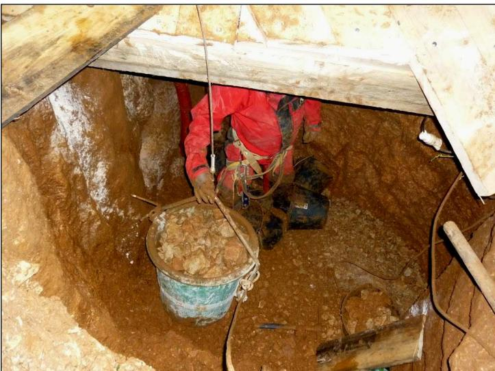
Le troisième toit pour protéger des chutes de pierres lors de la remontée de la benne de 70 litres de pierres et d'argile. En moyenne, 7 minutes par rotation : descente, chargement de la benne, montée !
